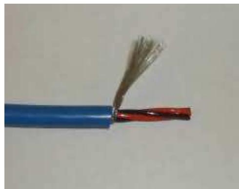
Wechseln Sie zur anderen Seite des Kabels. Isolieren Sie ca. 30mm des blauen Kabelmantels ab.
